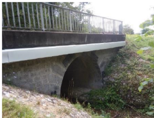
Pont sur l'Avance, au niveau de la RD154 - P02 (21/07/2023) E.KIM
